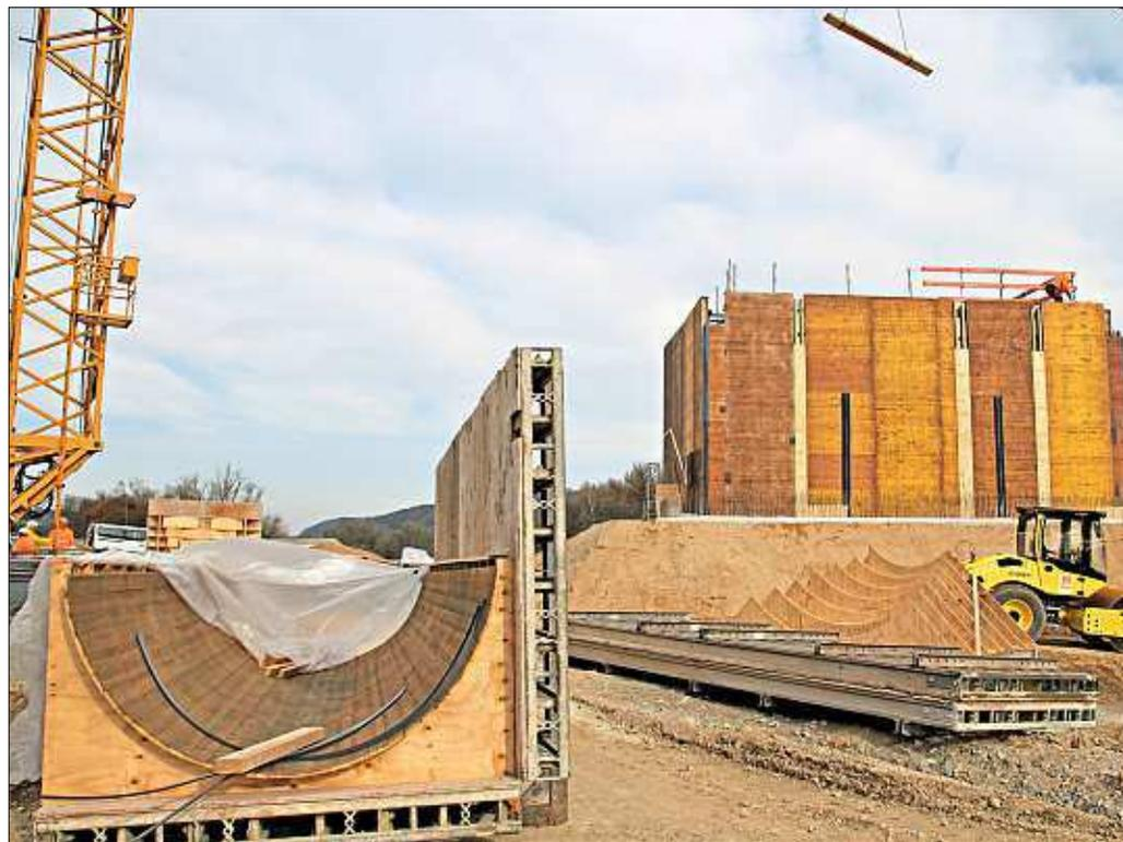
**Auf der Donauseite der B 8 entstehen Widerlager und Pfeiler für die neue Brücke.** Neun Meter hoch ist die Schalung, betoniert wird laut Staatlichem Bauamt bis zu einer Höhe von acht Metern.
