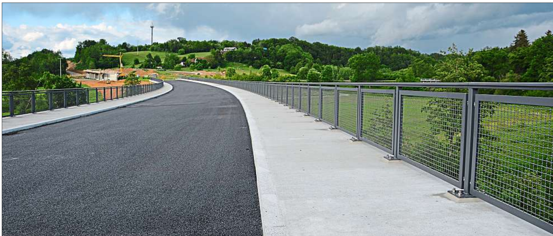
Die 159 Meter lange Brücke über das Wolfachtal ist fertig. Selbst das 1,10 Meter hohe Geländer ist montiert. Doch sollte hier nicht ein Fledermaus-Überflugschutz hinkommen? „Das wird erst später entschieden“, heißt es beim Staatlichen Bauamt Passau. Der Blick auf dem Foto geht in Richtung Galgenberg. – Foto: Baumgartl
