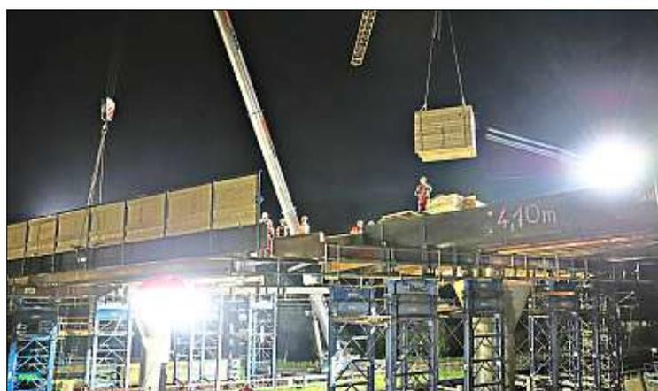
Seitenwände und Bodenschalung für die bevorstehenden Betonarbeiten werden in der Nacht eingebaut: So können die Arbeiter auch ohne Streckensperrung sicher über den Gleisen arbeiten.
