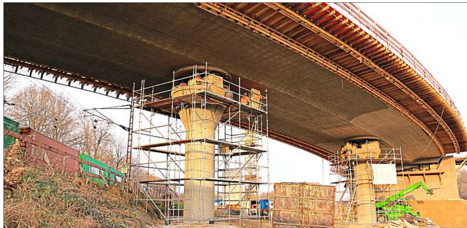
In den vergangenen Wochen ist die Brücke über die B 8 und die Bahnlinie abgesenkt worden. – Fotos: © Staatliches Bauamt Passau
