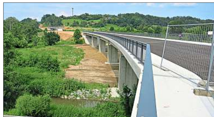
Die Brücke über die Wolfach ist fertig gestellt.
