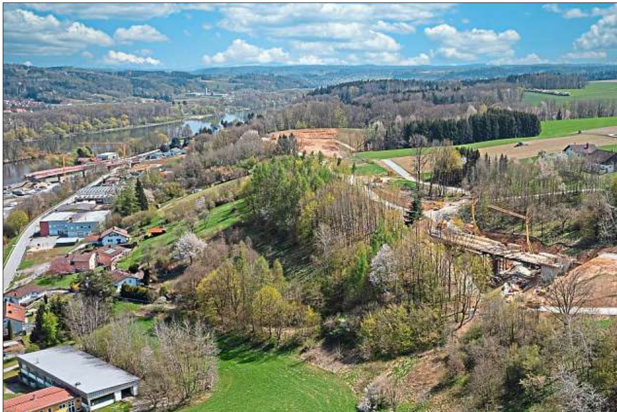
Bei der Talbrücke am Tobel am Galgenberg ist das Traggerüst für den Überbau fertig. Aktuell wird eingeschalt, im Anschluss wird der Betonstahl verlegt. Zur Orientierung: In der Bildmitte links das Asylbewerberheim.
