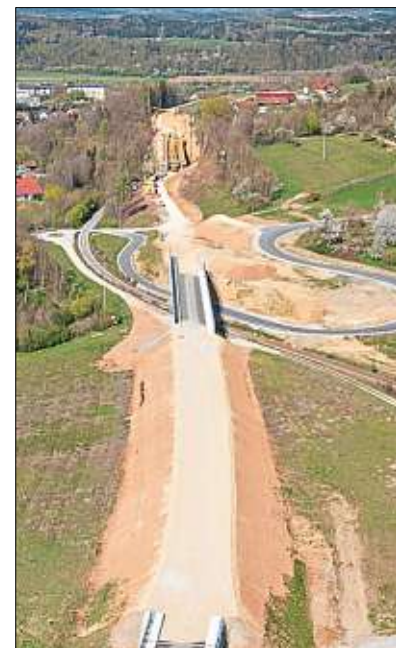
Die Brücke über die Wolfach und die Staatsstraße 2119 sowie die Brücke über die Bahnlinie Vilshofen-Blindham sind fertig, hier fehlt nur noch die Deckschicht des Straßenbelags. Die Galgenbergstraße wurde im Zuge der Arbeiten kurvenreich verlegt.
