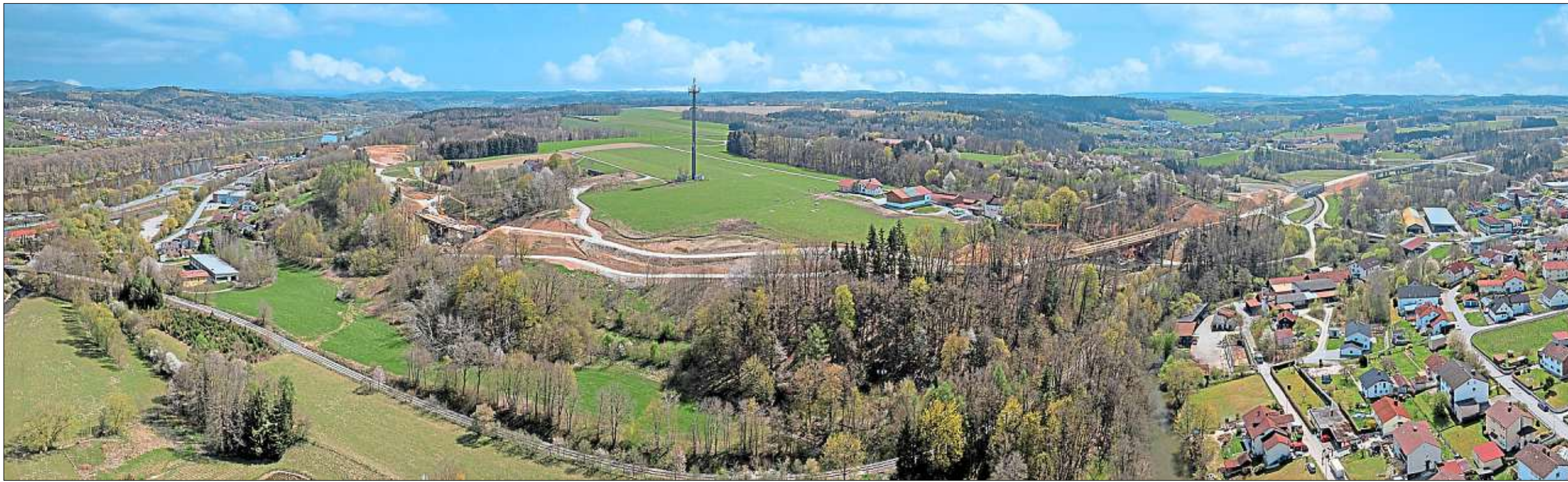
Die Umfahrung Vilshofen mit einer Länge von 3,3 Kilometern auf einen Blick: Am linken Bildrand beginnt die Baustelle am Ufer der Donau, geht hinauf zum Galgenberg, gräbt sich dort in den Hang unterhalb des Sendeturms und erreicht im rechten Bild-Drittel das Wolfachtal. Das restliche Teilstück zum Allinger Kreisel ist seit Herbst 2019 für den Verkehr schon freigegeben. – Fotos: Georg Laudi
