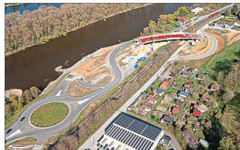
Das ist die auffälligste Baustelle der Umfahrung: Die Arbeiten an der Brücke über die B 8, die Bahnlinie und die Gemeindeverbindungsstraße. Man liegt gut im Zeitplan. Es laufen die Abdichtungsarbeiten für den Überbau, diese Woche wurden die Brückenkappen betoniert.
