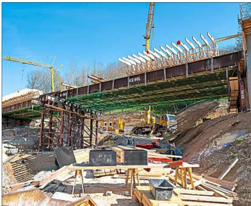
Mitten im Hang des Galgenbergs – für viele nicht einsehbar – entsteht eine Brücke über einen Taleinschnitt. Derzeit laufen die Bewehrungsarbeiten für den Betonstahl, außerdem werden die Spannstahtlitzten „eingeschossen“: Dabei handelt es sich um miteinander verwundene Stahlstränge, die später die Tragfähigkeit der Brücke garantieren. Der Überbau wird Ende Mai betoniert.
