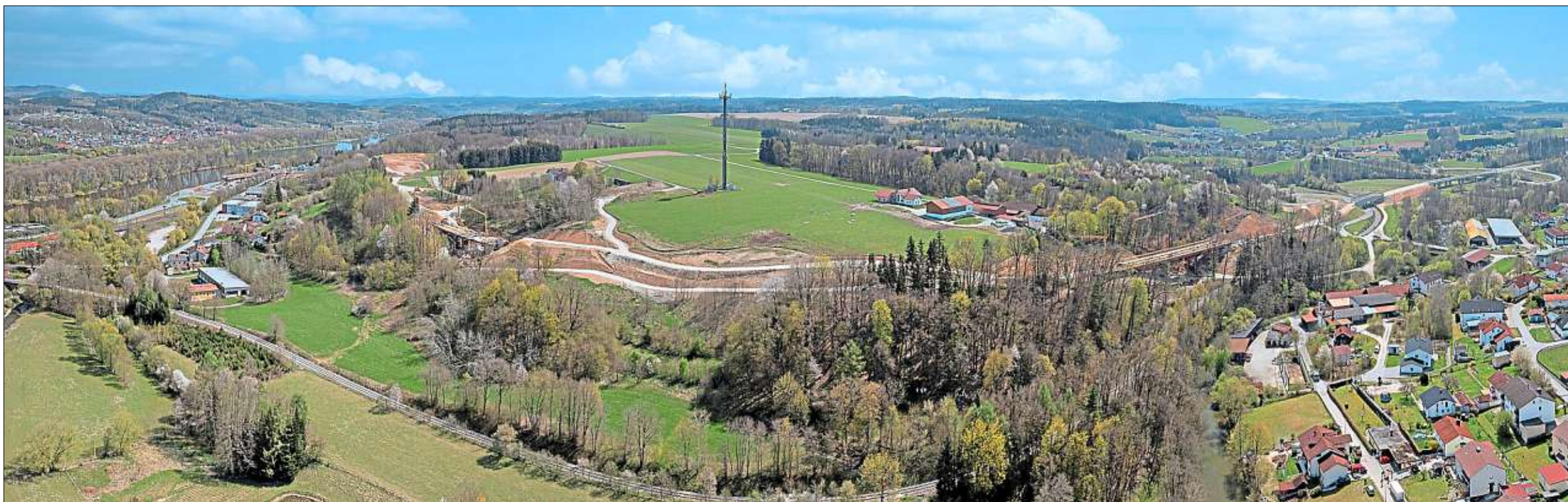
Die Umfahrung Vilshofen mit einer Länge von 3,3 Kilometern auf einen Blick: Am linken Bildrand beginnt die Baustelle am Ufer der Donau, geht hinauf zum Galgenberg, gräbt sich dort in den Hang unterhalb des Sendeturms und erreicht im rechten Bild-Drittel das Wolfachtal. Das restliche Teilstück zum Allinger Kreisel ist seit Herbst 2019 für den Verkehr schon freigegeben. – Foto: Georg Laudi
